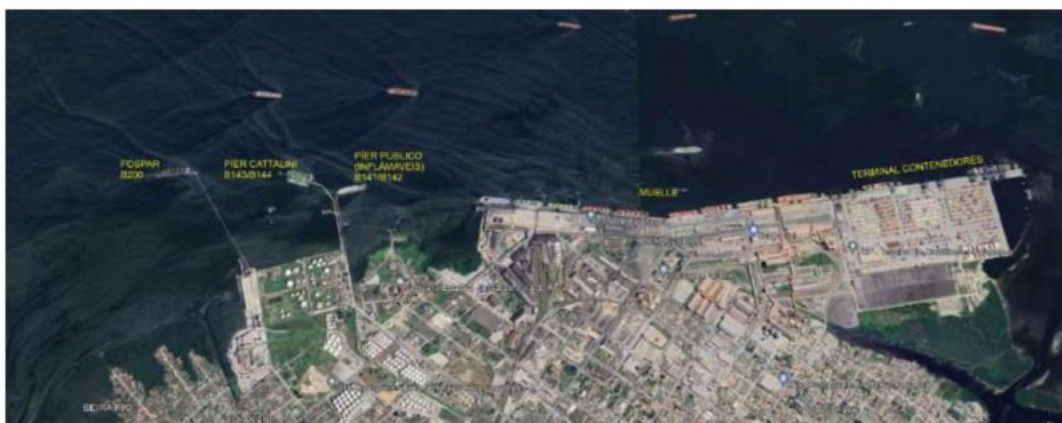
Figura 26. Berços do Porto de Paranaguá
