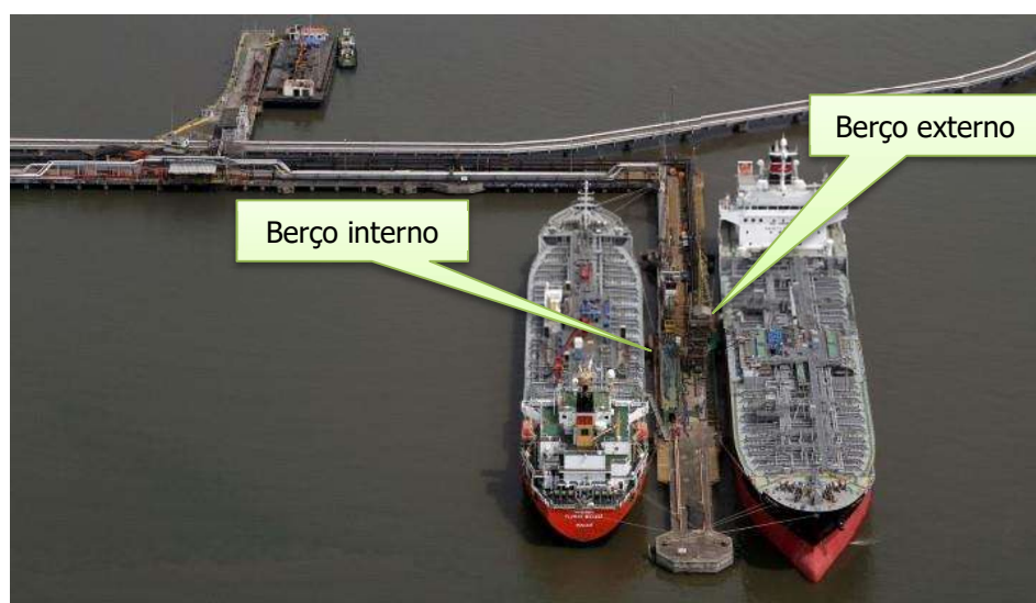
Figura 2 – Vista Superior do Píer Público de Inflamáveis Fonte: Sistema Ocepar – Informe Paraná Cooperativo
