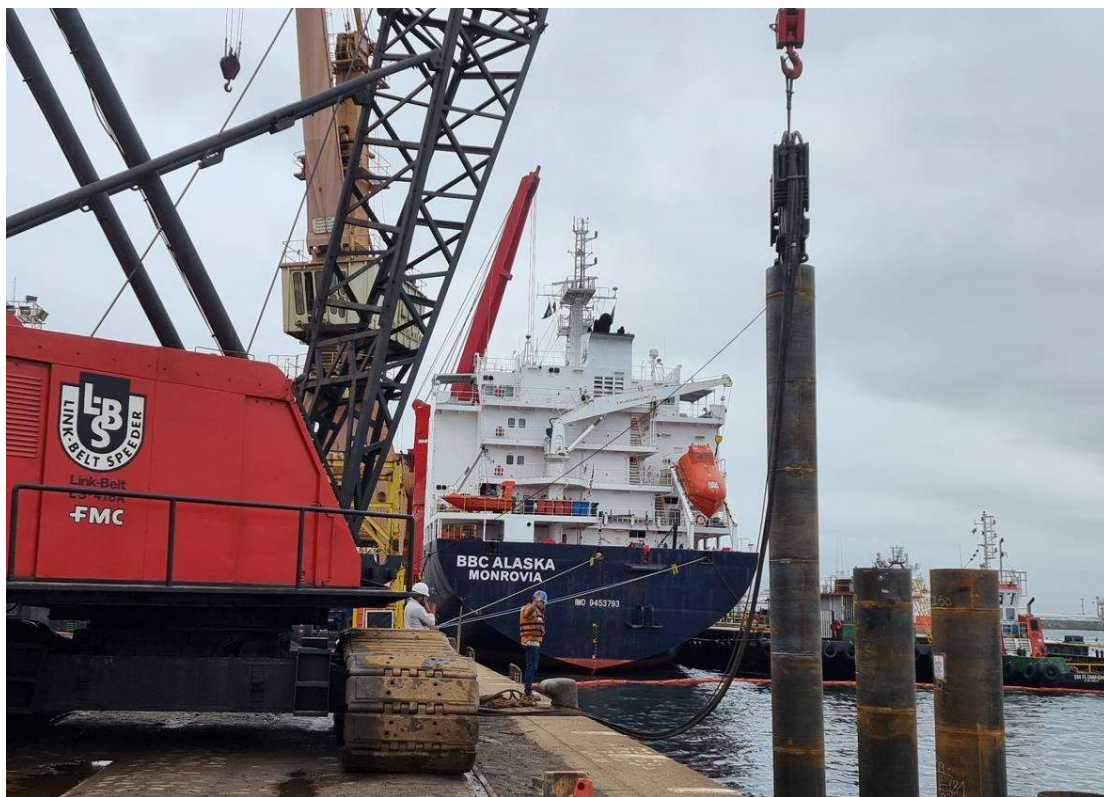
Figura 01 – CAT 46029/2025 – Cravação de estacas metálicas em água
