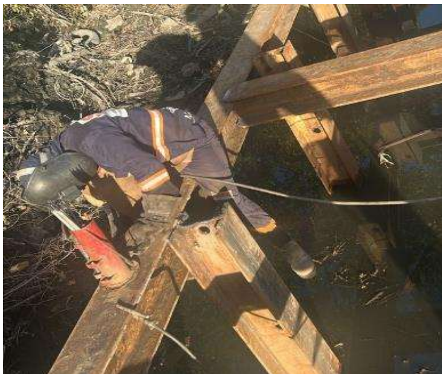
Figura 03 – CAT 2220634612/2025 - Montagem da estrutura metálica da plataforma provisória
