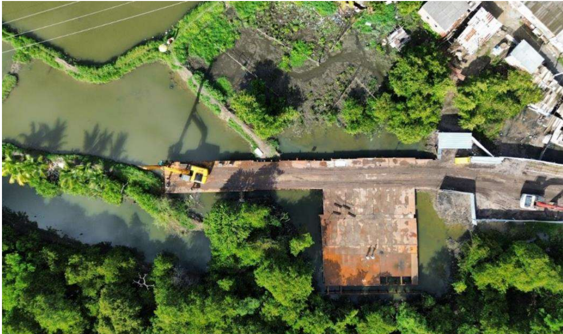
Figura 04 – CAT 2220634612/2025 - Cravação de estacas metálicas em água sobre plataforma em estrutura metálica
