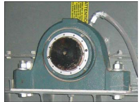
Sensor Instalado em Rolamento de Transportador de Correia
