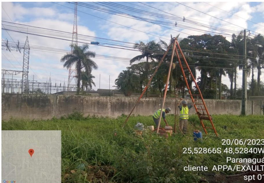
EXECUÇÃO DO SPT 01
