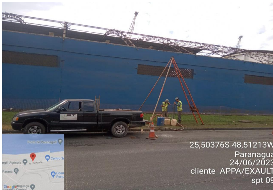
EXECUÇÃO DO SPT 09
