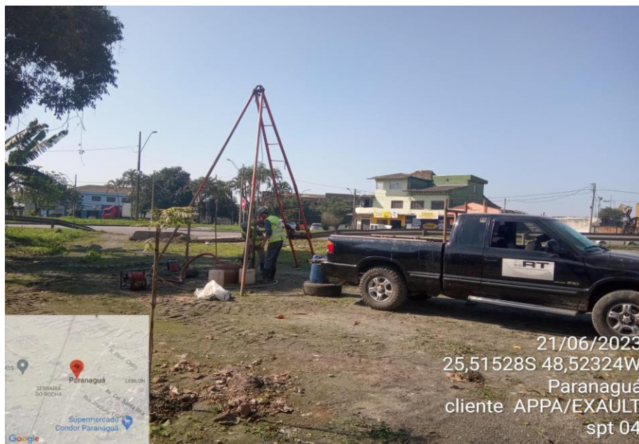
EXECUÇÃO DO SPT 04
