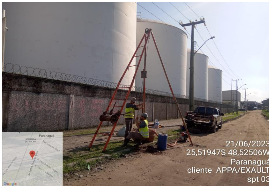
EXECUÇÃO DO SPT 03
