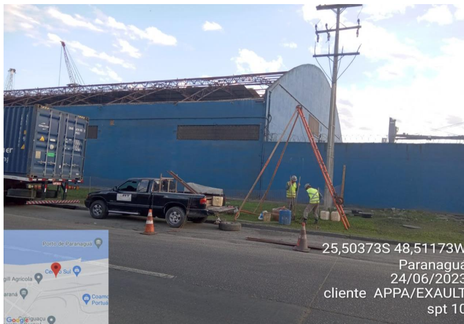
EXECUÇÃO DO SPT 10
