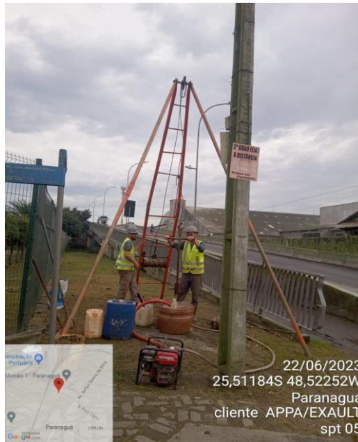
EXECUÇÃO DO SPT 05
