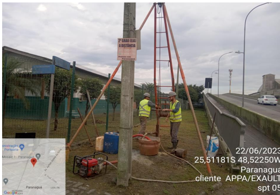
EXECUÇÃO DO SPT 05
