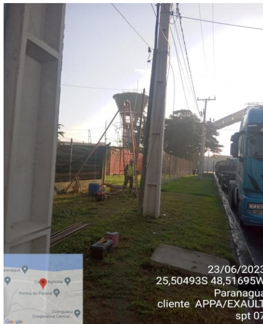
EXECUÇÃO DO SPT 07
