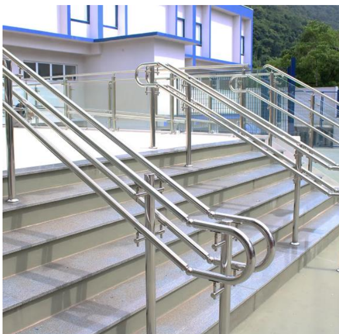
Figura 29 - Exemplo de guarda-corpo acessível NBR 9050
