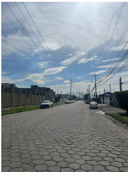
Figura 4: Condição atual da Rua Manoel Corrêa.
