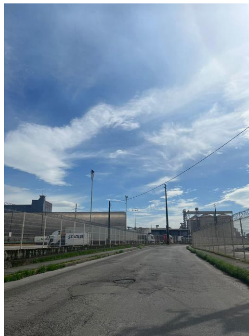
Figura 5: Condição atual da Rua Manoel Corrêa.
