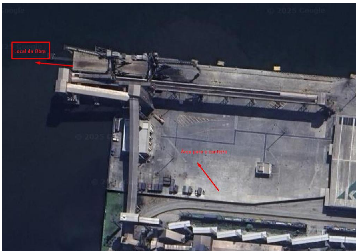
Figura 2 - Área para o canteiro de obras.
