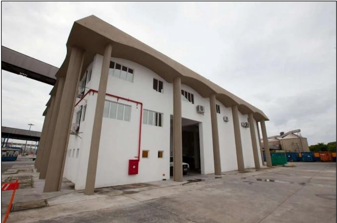
Figura 1 - Prédio/Edificação CPRE localizado no oeste do cais do Porto de Paranaguá.
