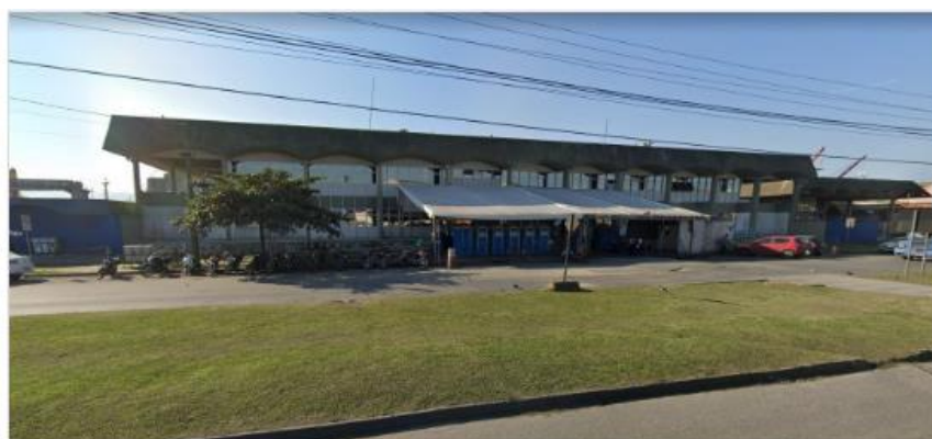
Figura 3 – Edificação Sede de Operações Portuárias
