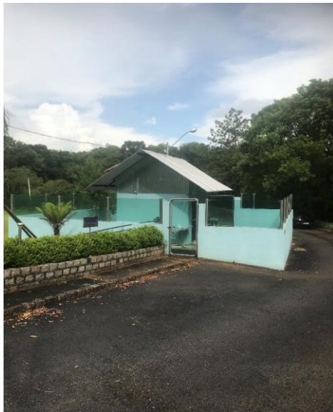
Casa de Proteção
