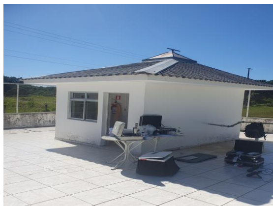
Casa de Proteção
