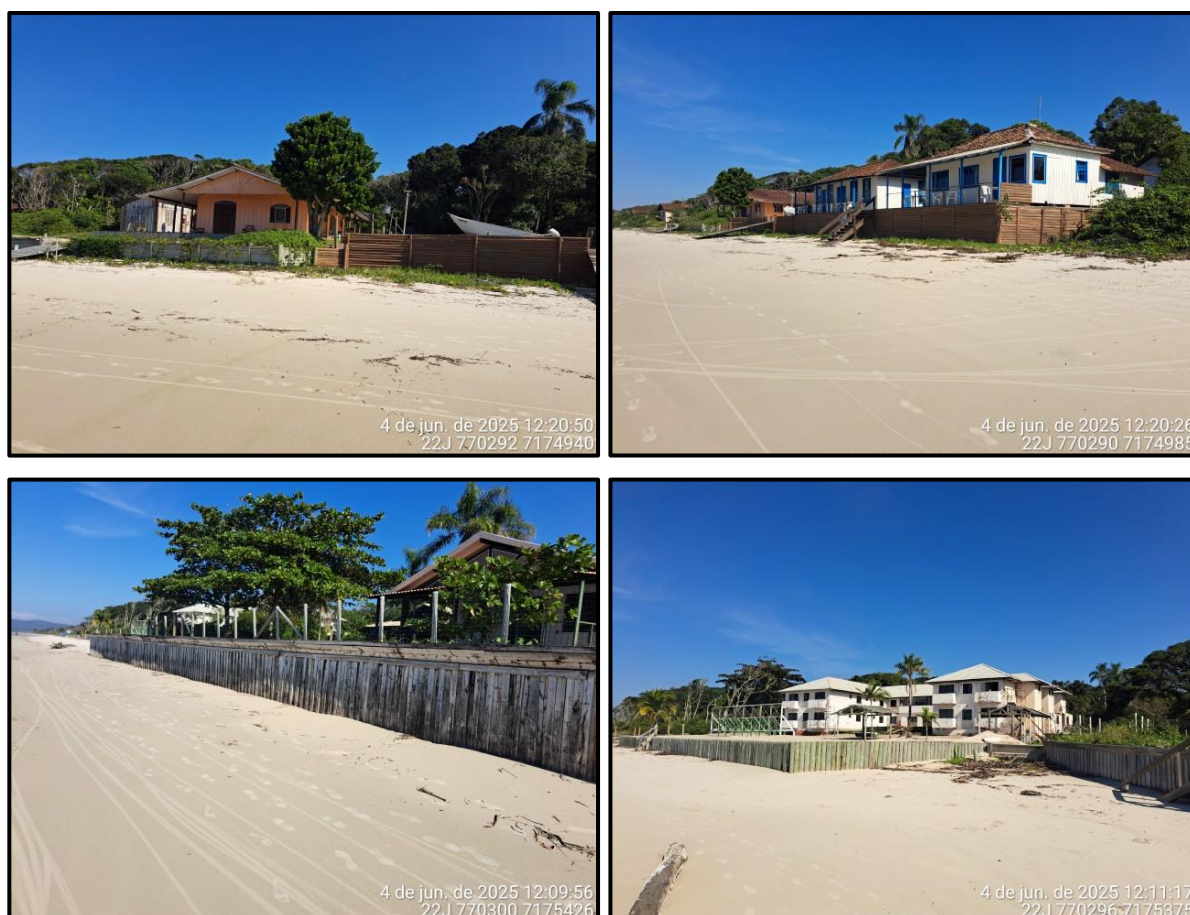
Figura 60 – Contenções de erosão costeira nas residências e pousadas a sul da Fortaleza.
