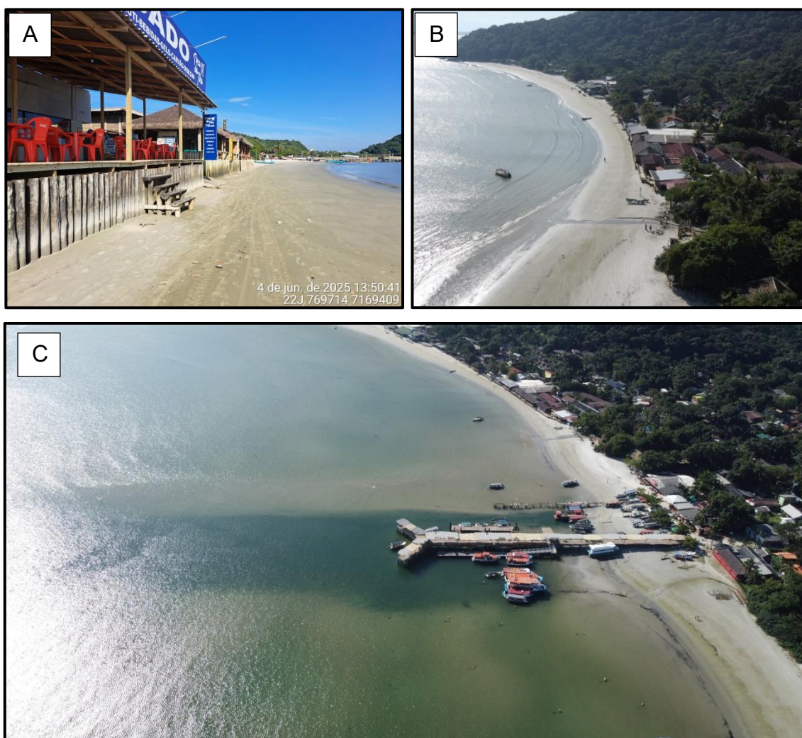
Figura 73 – (A) Proteção costeira realizada por proprietários de comércio na praia de Encantadas; (B) Avanço de estruturas de comércio sobre a praia; (C) Aprofundamento na morfologia de fundo provocado pela movimentação de embarcações próximo à praia.
