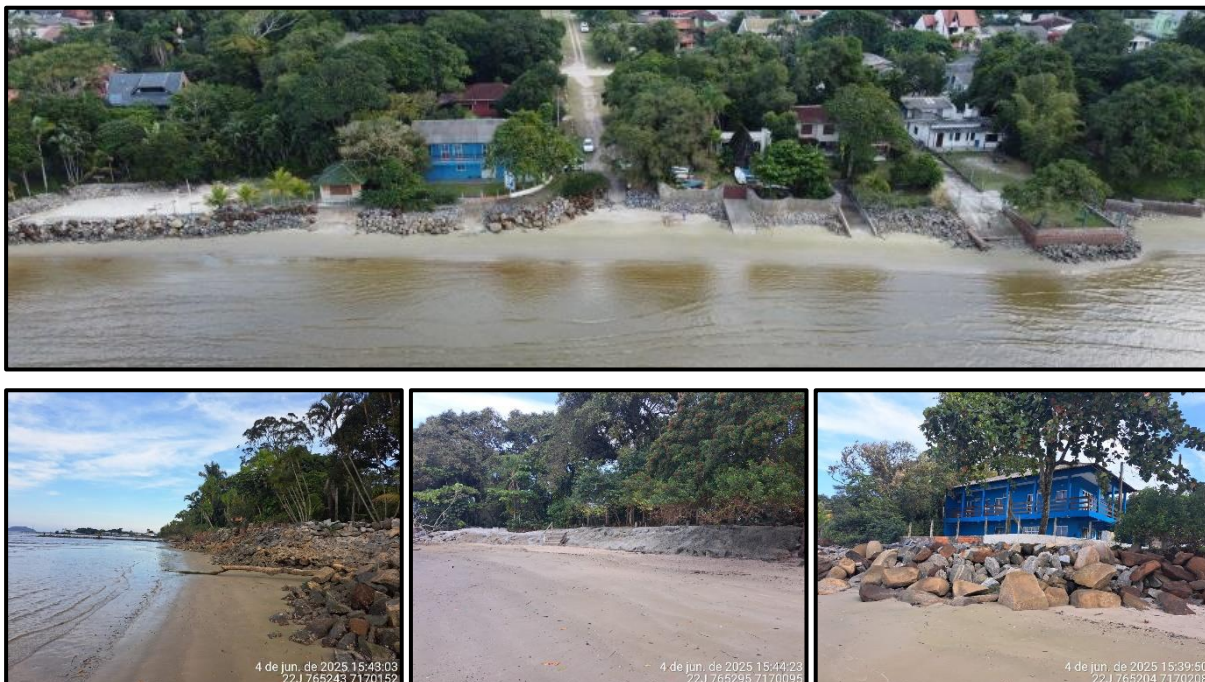
Figura 79 – Blocos de rocha e muros de concreto utilizados para estabilização de linha de costa em Pontal II, Pontal do Paraná.
