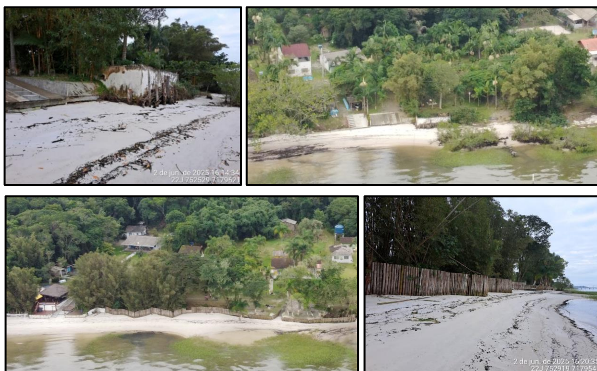
Figura 54 – Estruturas de contenção a erosão costeira para resguardar perda de propriedade ou território na comunidade de Piaçaguera.
