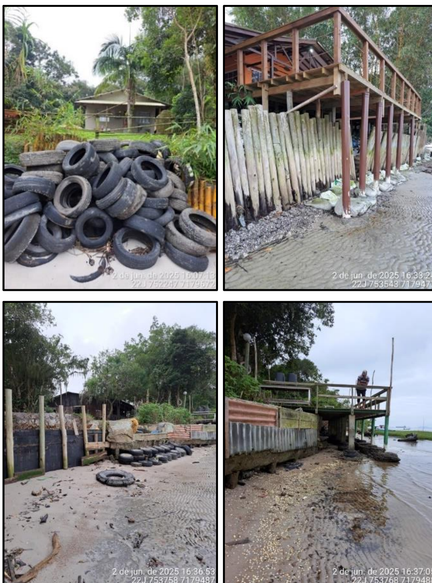
Figura 53 – Estruturas e materiais utilizados para mitigar processos erosivos de linha de costa em Piaçaguera.
