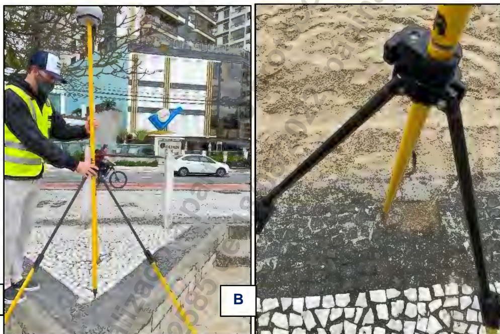
Figura 3. (A) Instalação dos RNs na praia Central de Balneário Camboriú. (B) Marco localização do RN. Os RNs foram fixados de acordo com a viabilidade da praia, ou seja, evitando locais em que os marcos ficassem expostos à erosão, assim como a ação antrópica (vandalismo).
