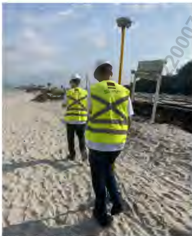
Figura 4. Registro do levantamento topográfico para medição da alimentação na estaca 5+600.
