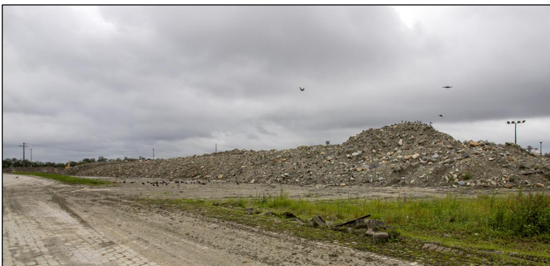
Figura 27: Material no P16 proveniente da derrocagem das pedras da Palangana.
