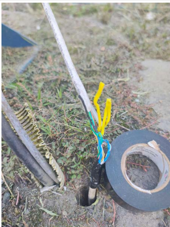
Feito conexões com termo retrátil Gate saída/rua
