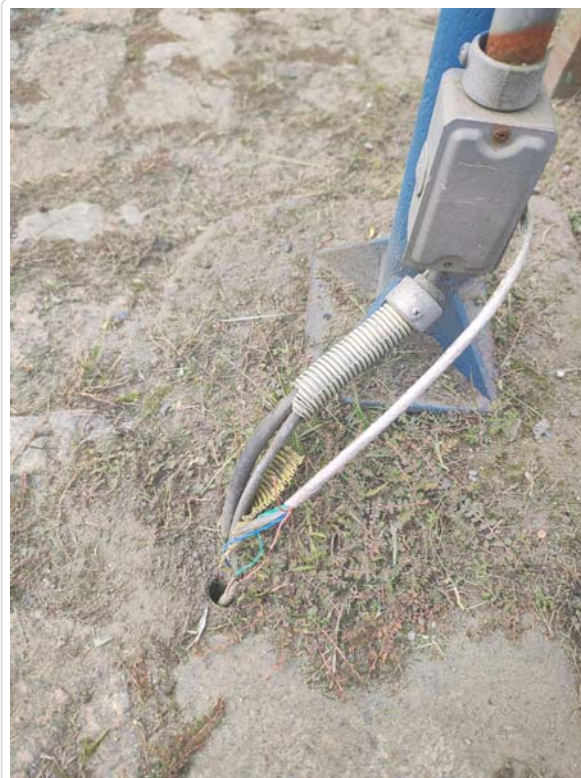
Balança saída cabo semáforo
