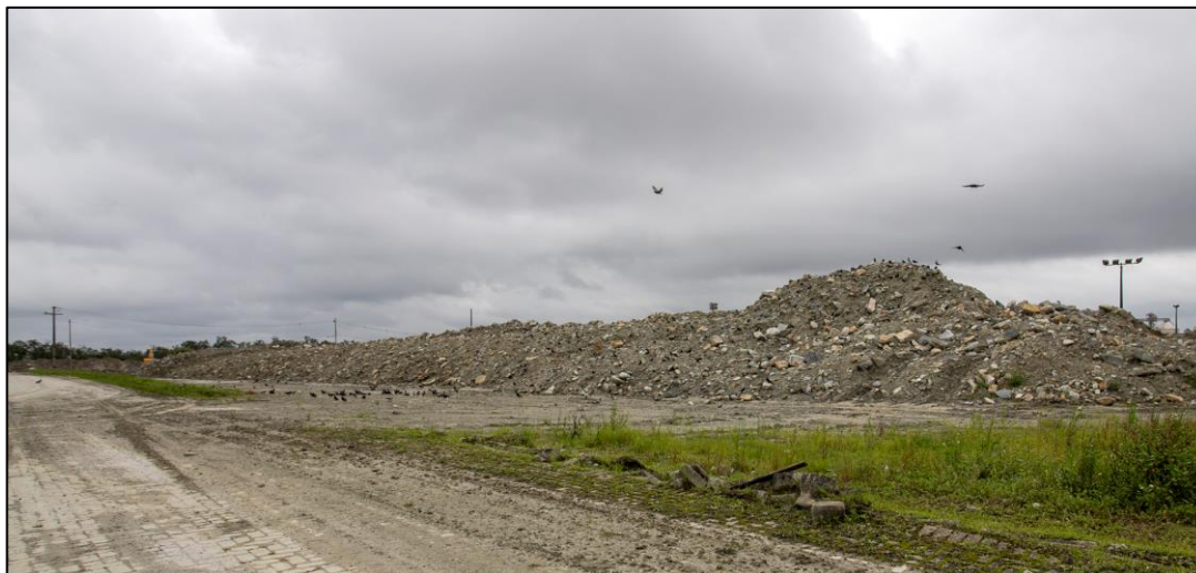
Figura 28: Material no P16 proveniente da derrocagem das pedras da Palangana.
