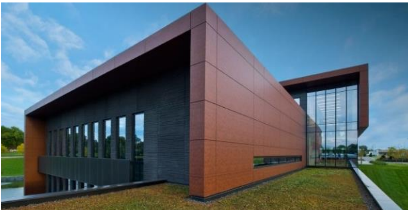
Figura 24 - Exemplo de ACM amadeirado aplicado à fachada
