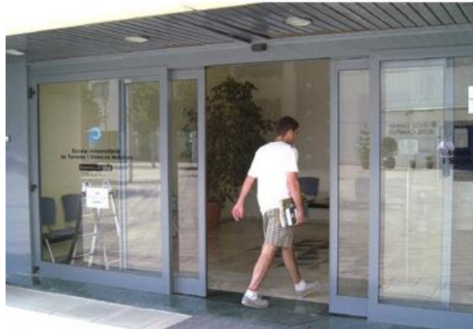
Figura 36 - Exemplo de porta automática com sensor e presença
