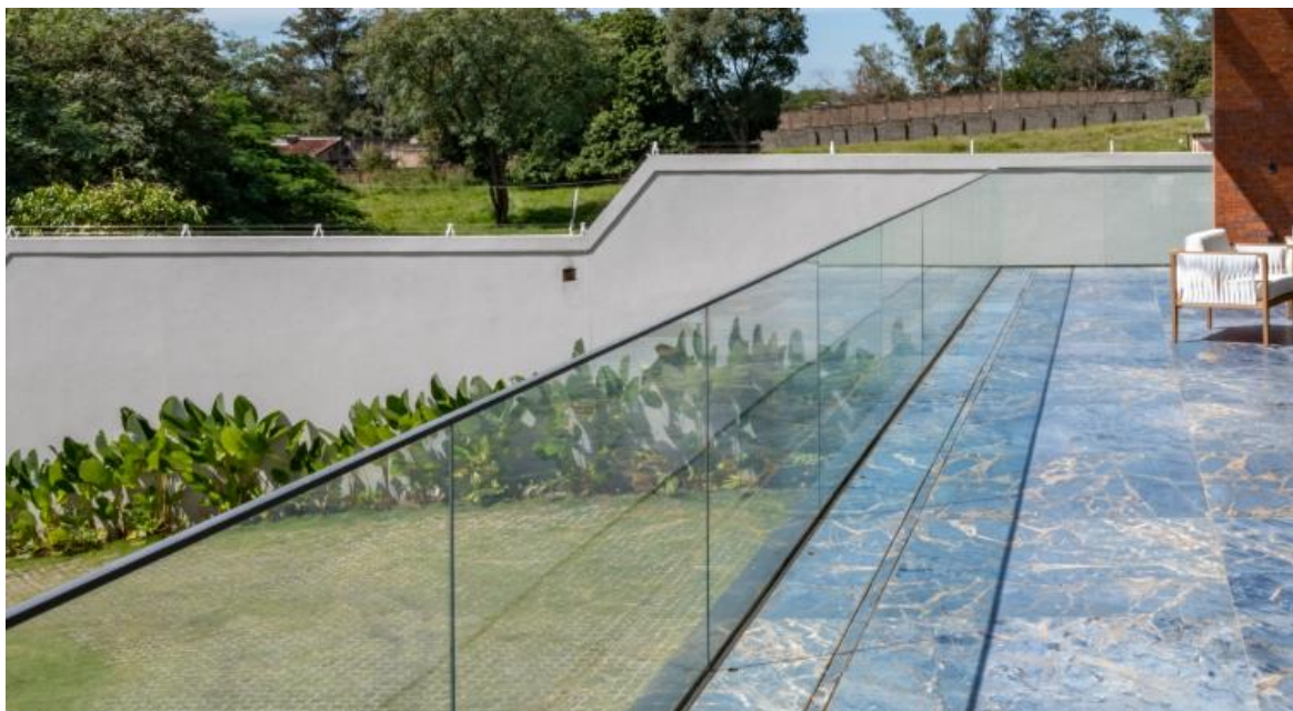
Figura 30 - Exemplo de guarda-corpo de vidro embutido no piso
