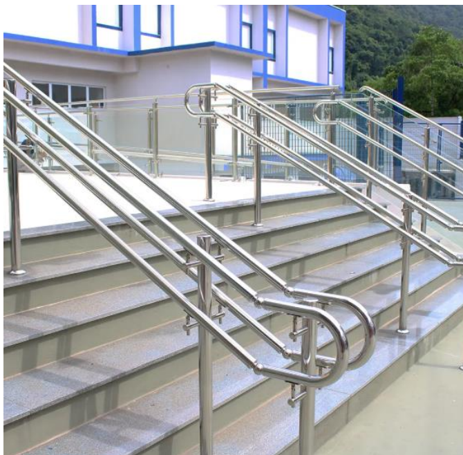
Figura 29 - Exemplo de guarda-corpo acessível NBR 9050
