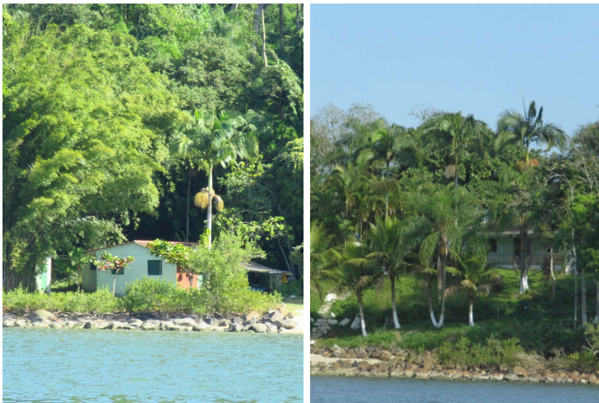
Figura 133 - Ocupações de não-índios na borda norte da Ilha da Cotinga (oposta à aldeia indígena)
