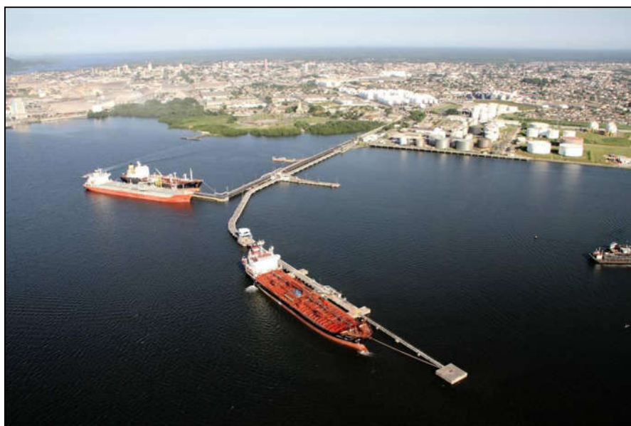
Figura 5. Vista aérea do píer de granéis líquidos e inflamáveis. Fonte: APPA (2010).
