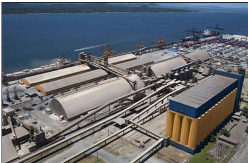
Figura 7. Corredor de Exportação e Silo Vertical do Porto de Paranaguá. Fonte: APPA (2010).
