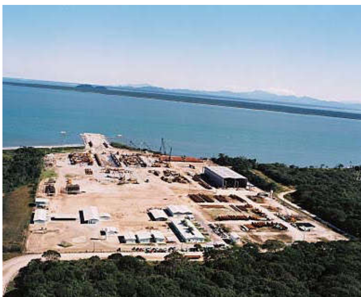
Figura 174. Estrutura do canteiro de obras da TECHINT.
