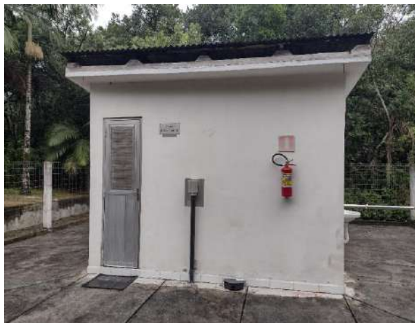
Casa de Proteção do Poço
