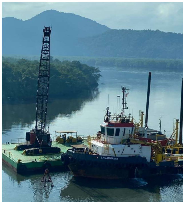
Figura 3: Clamshell sobre flutuante (TBC Conquistar) e nivelador de fundo (Sagamorim II).
